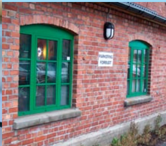
Fabrikkbygg med nye velisolerte sprossvinduer.
