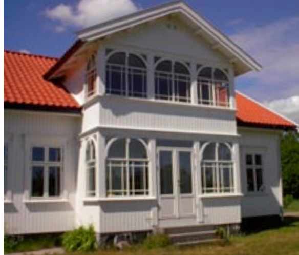
Gammel glassveranda med nye vinduer.
